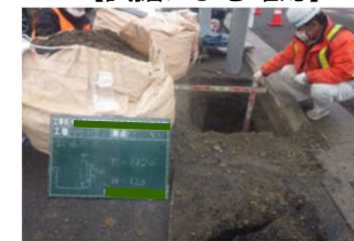
【試掘による確認】
