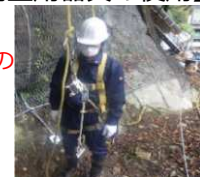
【墜落制止用器具の使用】
