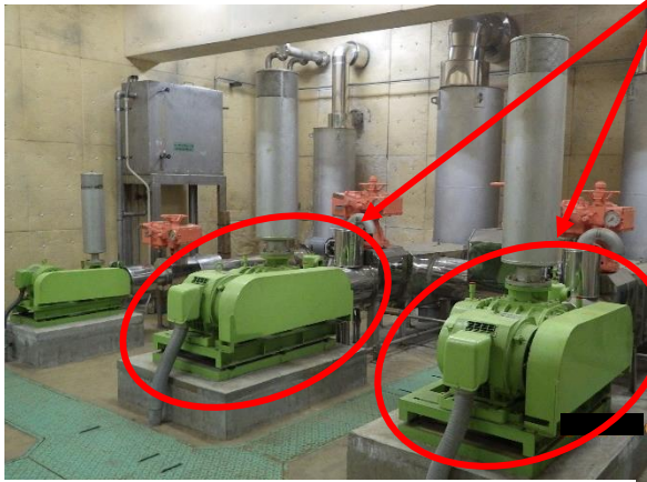
ブロー室（霞ヶ浦樋管側）
