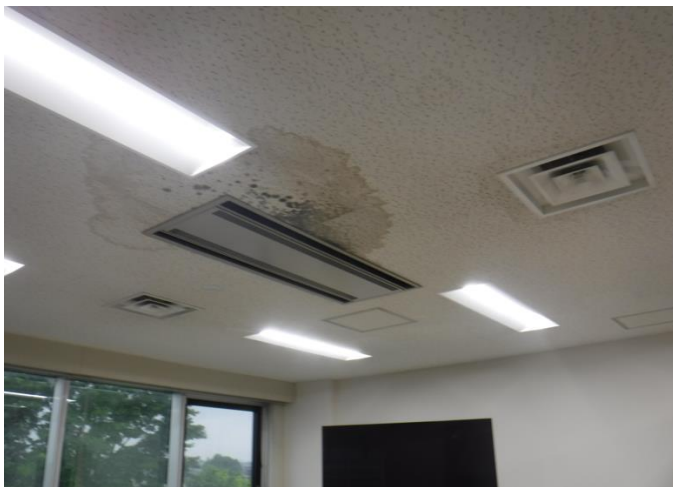
室内状況 (第二会議室)
