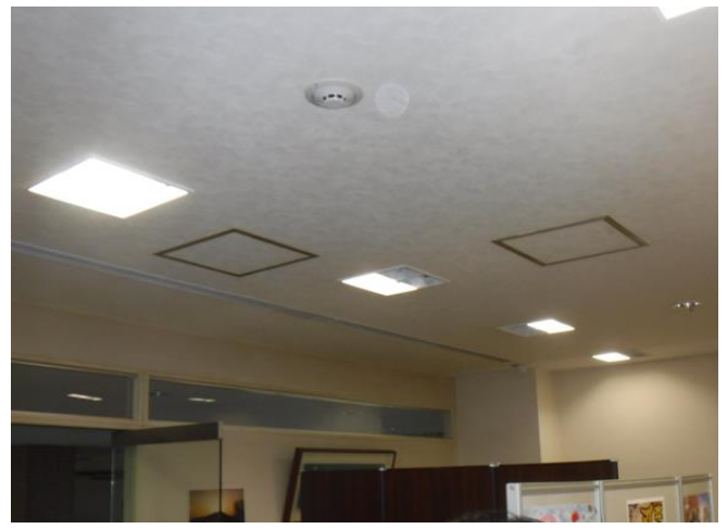
室内状況 (客溜り)
