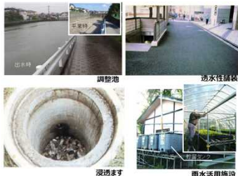
雨水貯留浸透施設の例
