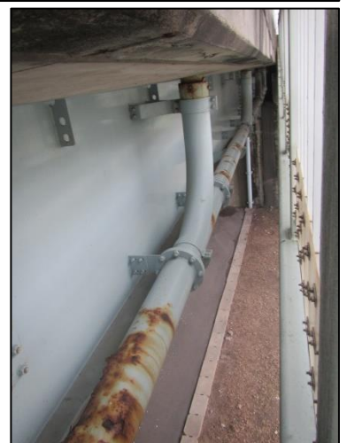
橋梁排水管清掃
