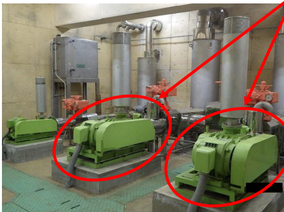
ブロー室（霞ヶ浦樋管側）
