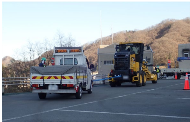
グレーダーによる牽引
