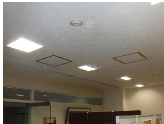
室内状況（客溜り）
