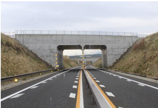
今回点検箇所
