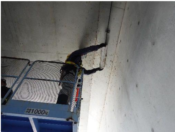
点検作業イメージ
