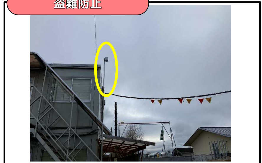
現場内での監視カメラの設置
