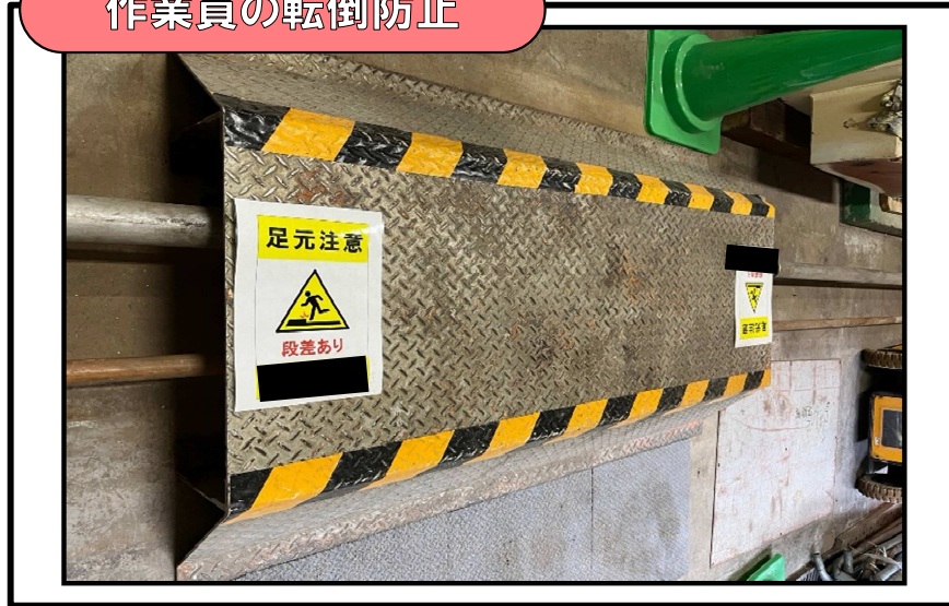
段差への「足元注意」の表示
