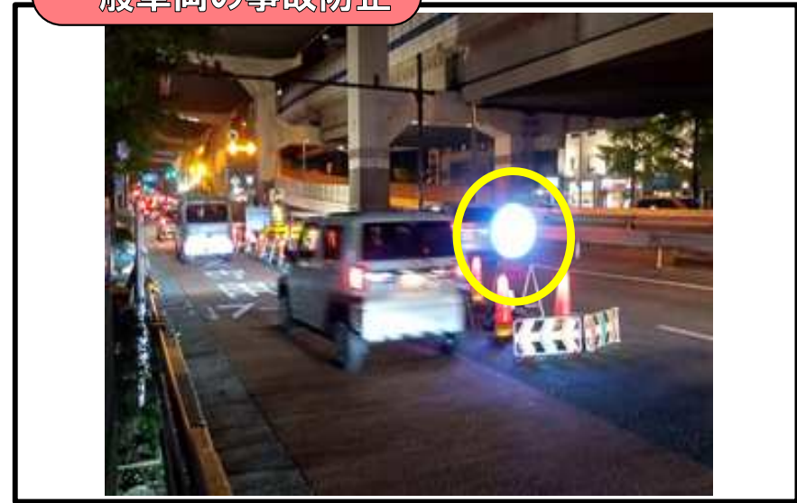
導流帯の先端に高輝度のLED照明を設置
