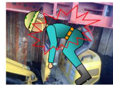
操作を誤り、土留支保とバックホウの間に挟まれた事案
