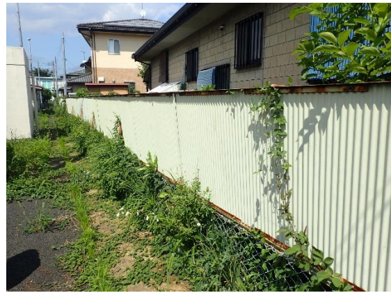
既存フェンス 2
