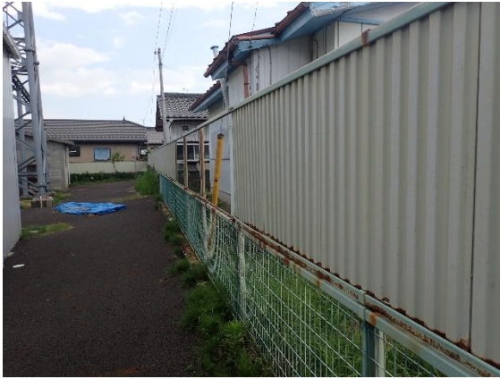
既存フェンス 1
