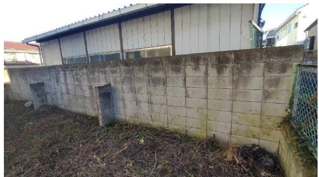
ブロック塀外観
