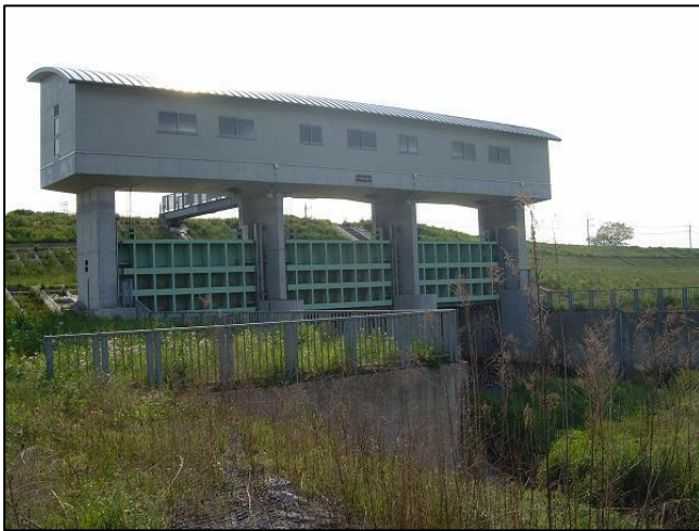
1. 江川排水樋門
