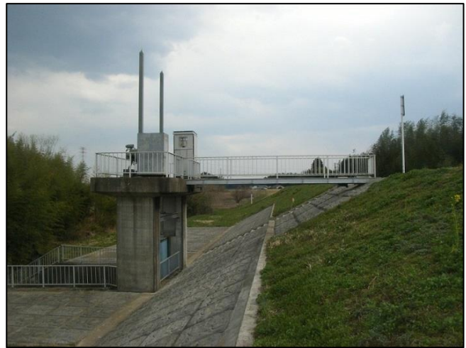
2. 神崎排水樋管
