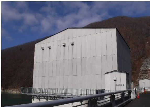
建物外部状況
