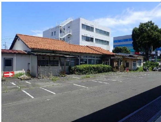
解体建物（南西より）
