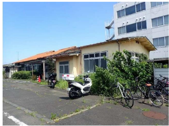
解体建物（東西より）
