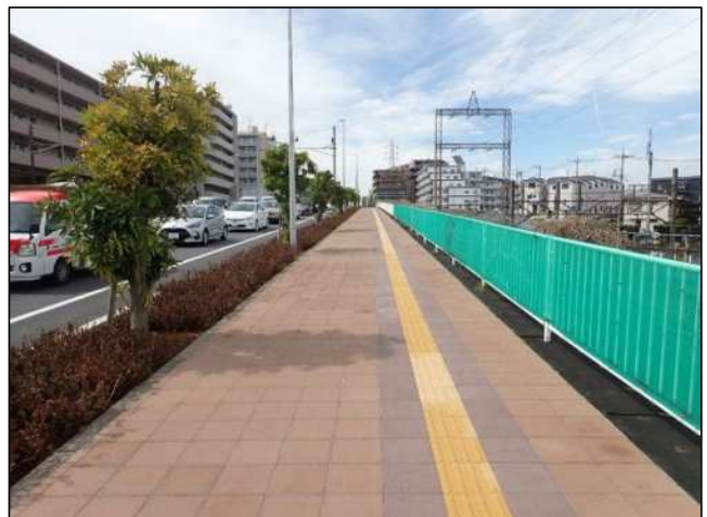
完成(歩道舗装)
