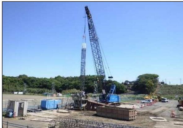
場所打杭 施工状況
