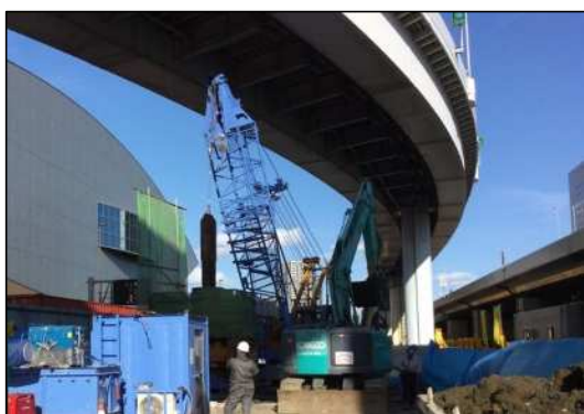
場所打ち杭施工状況
