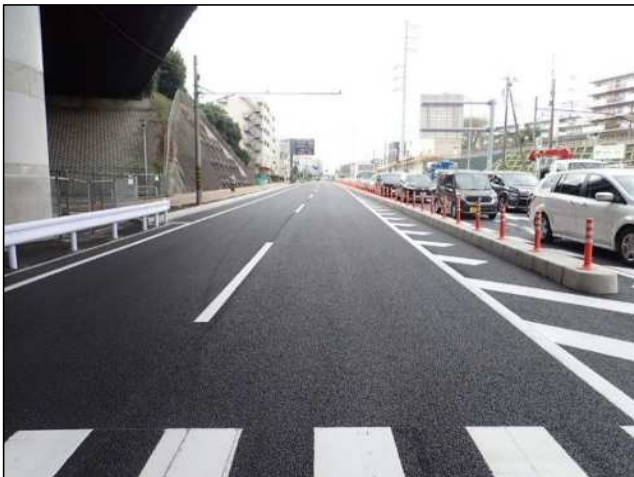
完成(車道舗装)
