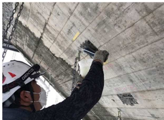
コンクリート補修状況
