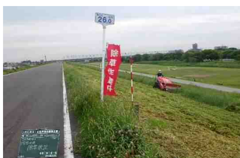
堤防除草施工状況
