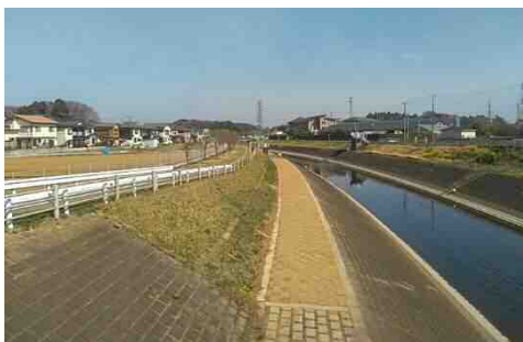
流山地区 護岸補修完成
