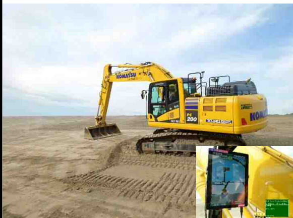
ICT施工_バックホウによる法面整形
