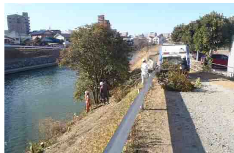
樹木伐採施工状況
