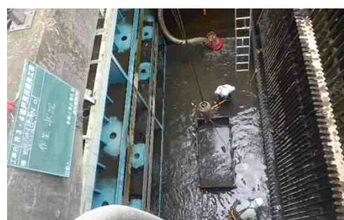
除塵機部土砂撤去状況
