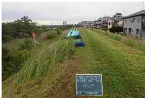
除草施工状況
