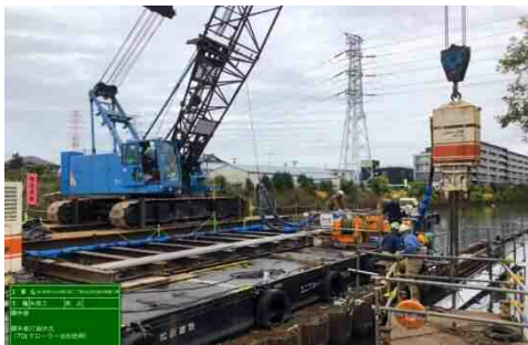
鋼矢板打設状況
