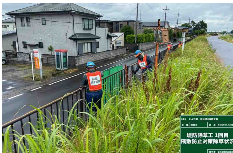
堤防除草施工状況
