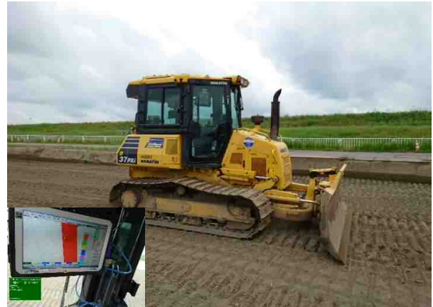
ICT施工_転圧管理
