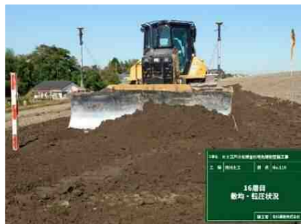
盛土施工状況
