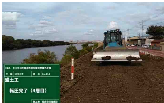
盛土施工状況
