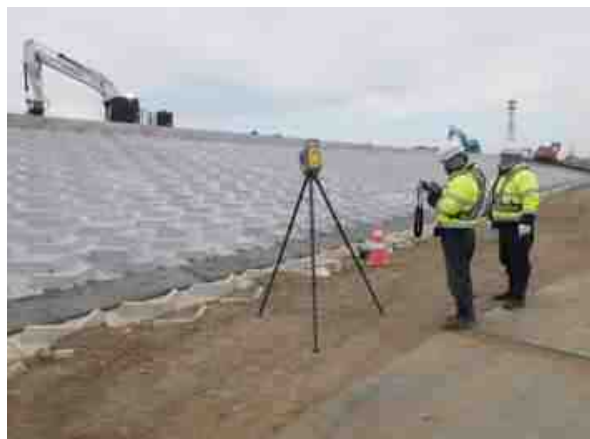
3次元出来形計測_護岸(地上型LS)
