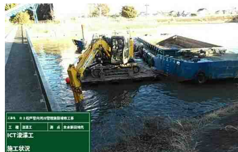
松戸地区 土砂撤去状況
