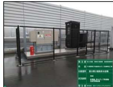
地上機器設置完了
