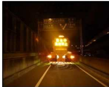
凍結防止剤散布状況
