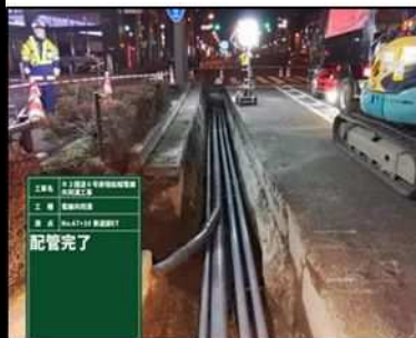
電線共同溝施工状況
