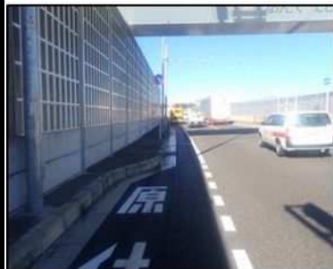
路面清掃状況
