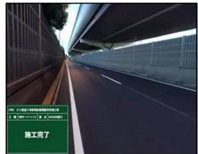
舗装打換え完了
