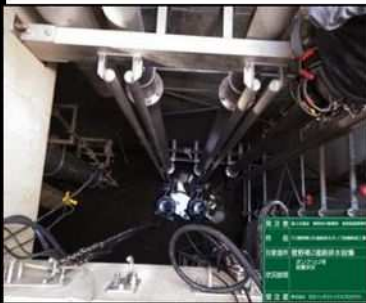
排水ポンプ設置状況
