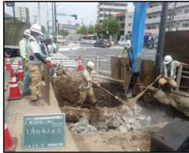
支障物撤去状況
