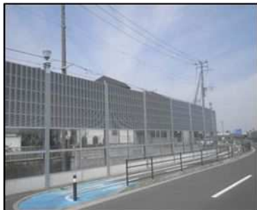
遮音壁設置状況
