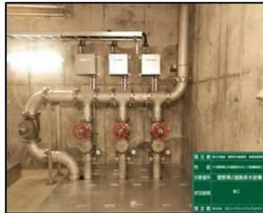
排水ポンプ設置完了
