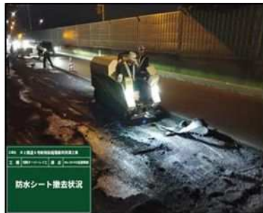
防水シート撤去状況
