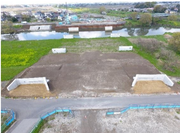
【完成（橋脚2基、橋台2基）】
