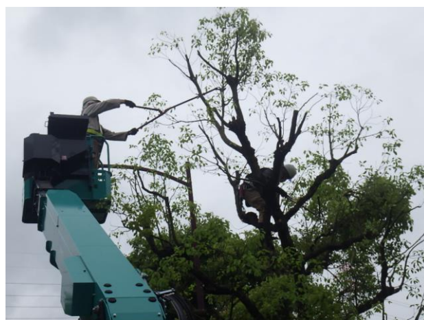
【高木剪定施工状況】
