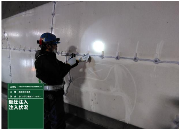
【ひび割れ補修工施工状況】
