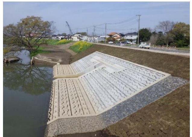
【完成（付替放水路）】
