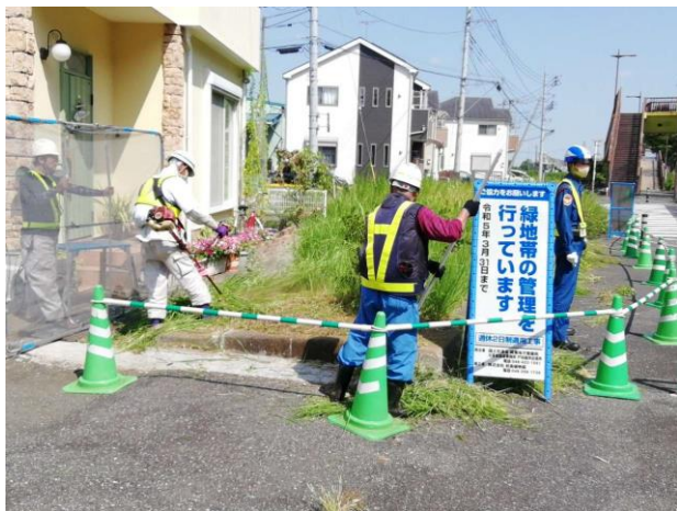
【除草工施工状況】
