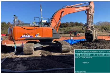
【ICT地盤改良 施工状況】
