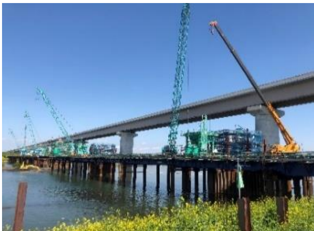
【橋脚施工状況】
