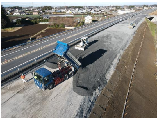
【ICT盛土施工状況】
