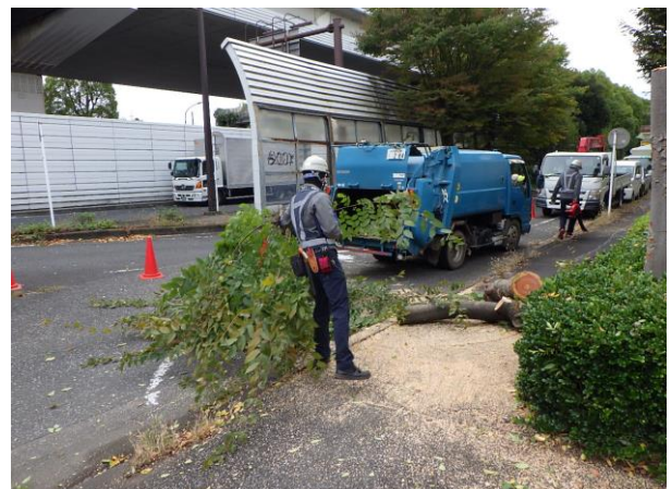
【応急処理工作業状況】
