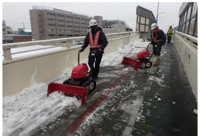
【除雪状況（応急処理工）】
