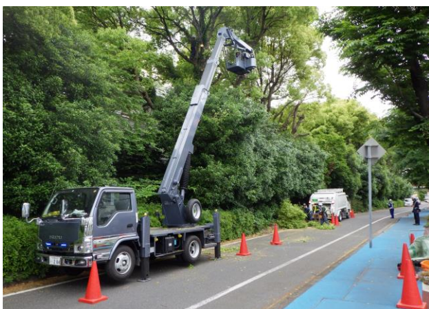
【高木剪定施工状況】
