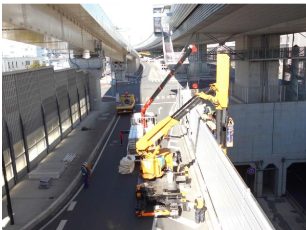
【遮音壁パネル設置状況】
