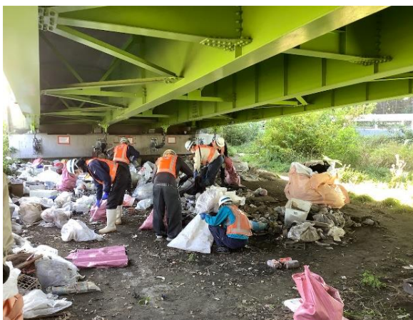
【清掃状況（応急処理工）】
