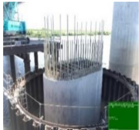
【橋脚躯体施工状況】
