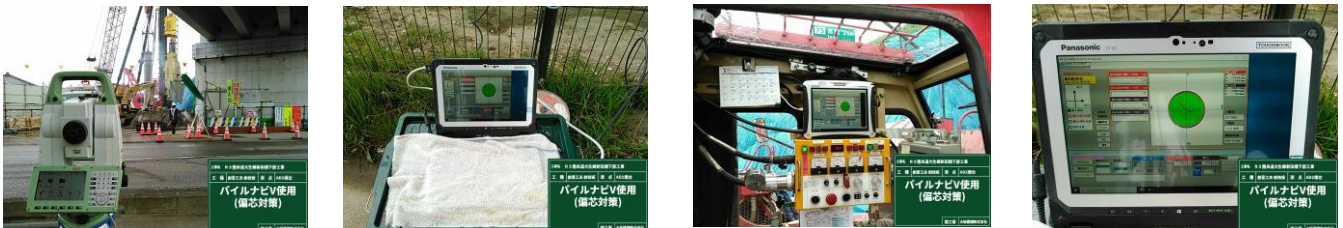
【新技術を活用した杭打設状況】
