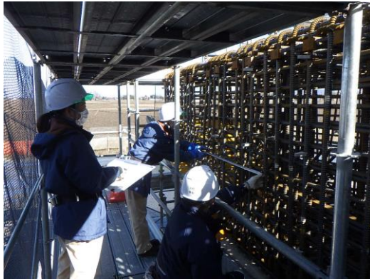
【女性技術者による鉄筋出来形計測】
