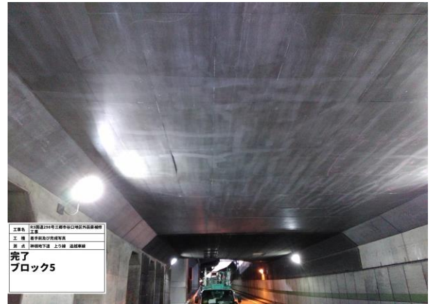
【表面保護工完了】
