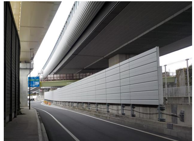
【遮音壁設置完了】
