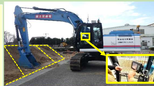
3次元マシンガイダンス搭載バックホウによるICT施工実習
