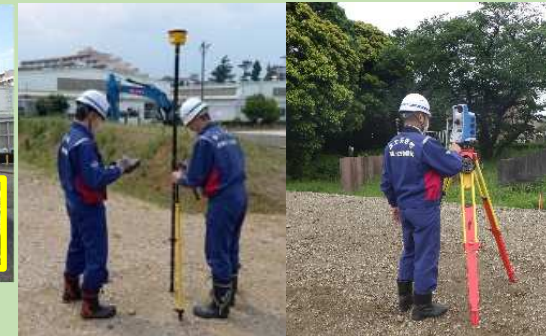
3次元計測機器による起工測量実習
