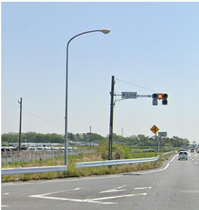
道路照明灯（建替）
