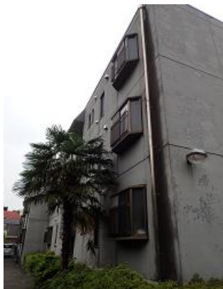
建物外観状況
