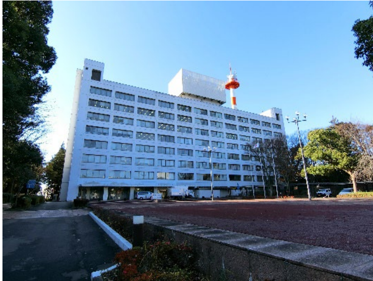
研究本館北側外観
