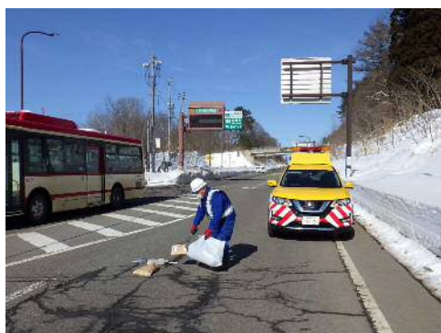
道路巡回 (落下物回収)
