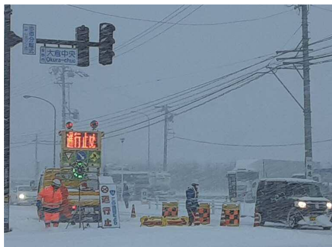
集中除雪実施のための通行止め状況
