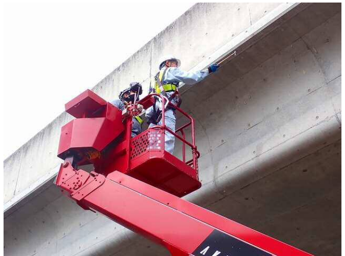
いなさとし 国道19号稲里西ランプ橋点検状況(近景)
