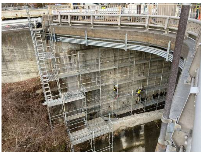
しんさんせいじ 国道19号新山清路橋橋梁補修状況
