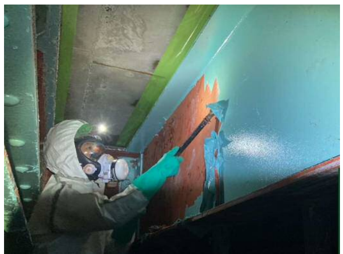
ほかり 国道19号穂刈橋塗膜除去作業状況
