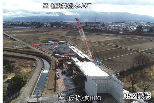
松本市波田地区の工事状況
