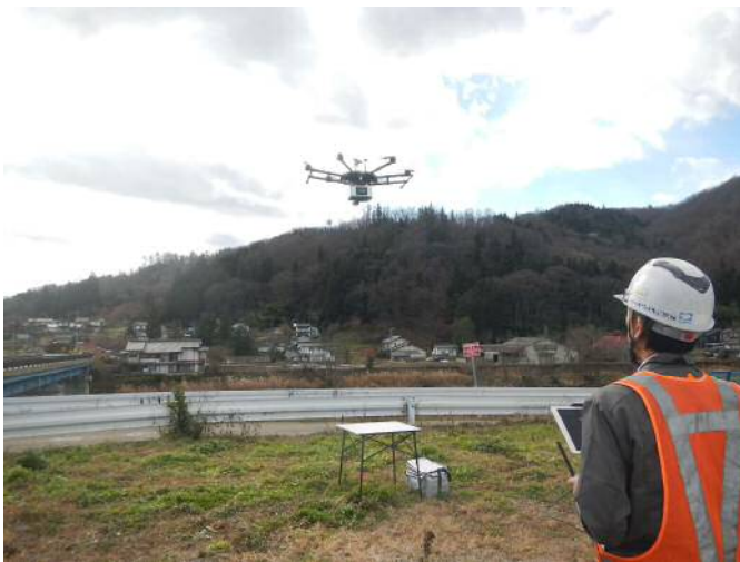
むつみ 国道19号睦橋点検状況(遠景)
