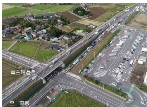
② 幸主跨道橋付近
