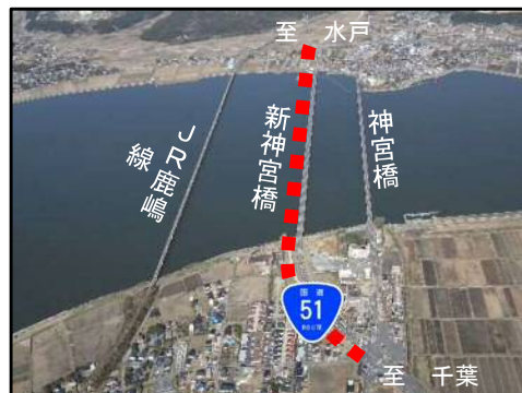
国道51号神宮橋架替周辺の状況
