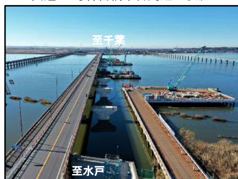
橋梁下部工の施工状況（令和4年12月撮影）
