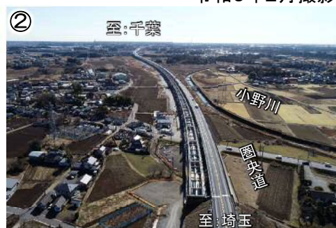
つくば中央IC～つくばJCT(館野高架橋付近)
