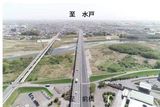
① 新川島橋の施工状況
