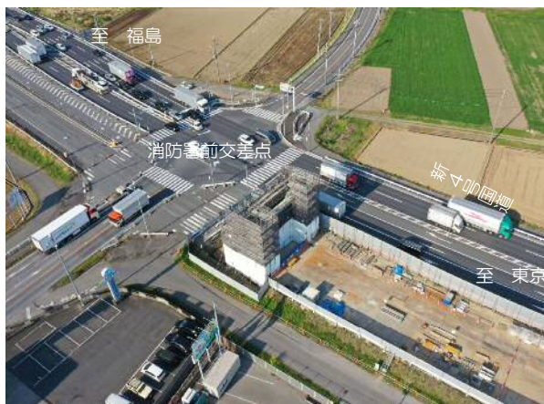
①（仮）元栗橋跨道橋（消防署前交差点）付近
