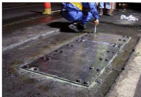
荒川河口橋のあて板設置状況
