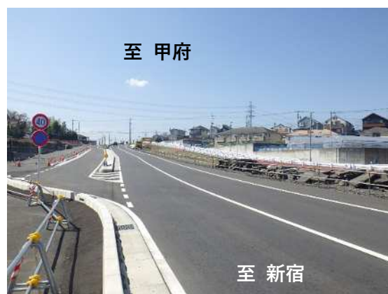
② 豊田南地区 整備状況 (令和5年3月撮影)
