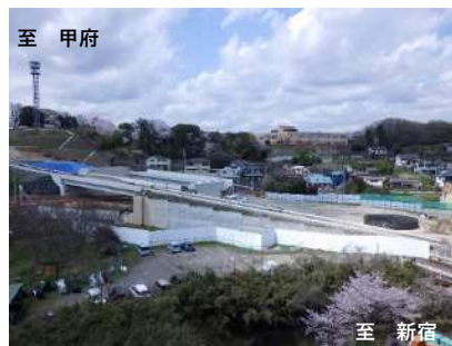
② 寺田地区側道橋 寺田地区から甲府方向を望む (令和5年3月撮影)
