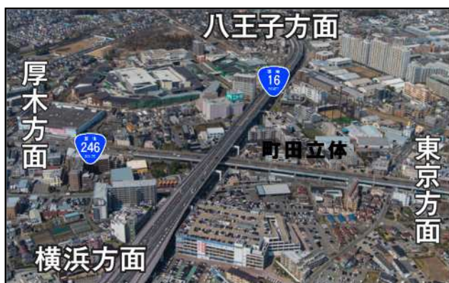
①町田市南町田付近
