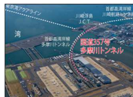
多摩川トンネル予定地付近
