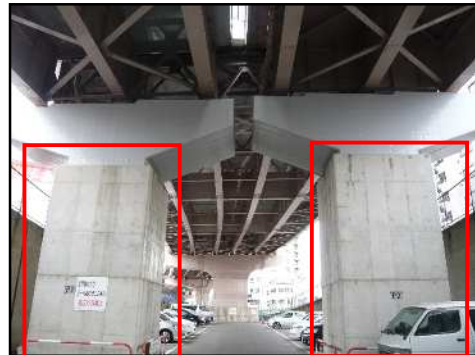
コンクリート巻立による橋梁補強
