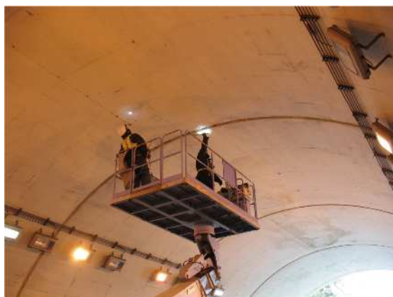
トンネル点検の様子
