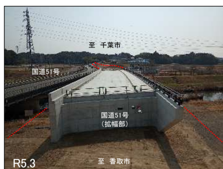
成田拡幅(東金山橋)
