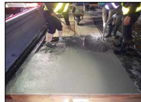
▲床版架替状況 (コンクリート打設)
