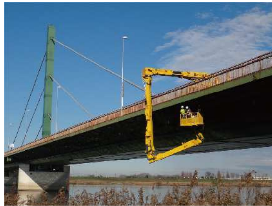
橋梁点検の様子
