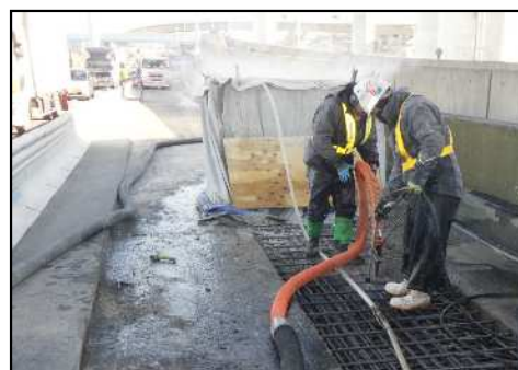
▲床版架替状況 (既設床版の撤去)
