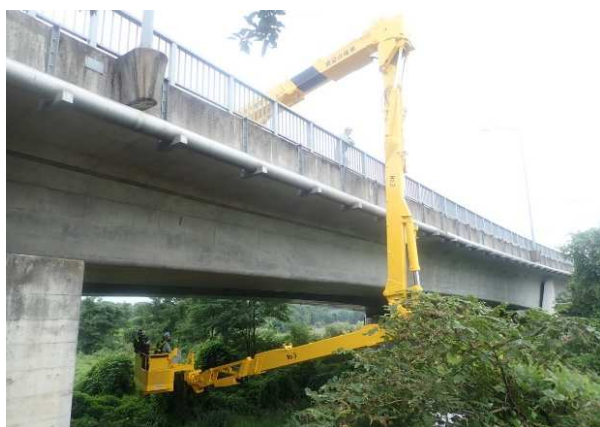
橋梁点検車による点検状況（ あ が つ ま し ん ば し 吾妻新橋）
