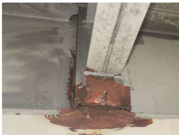
— ひ ろ さ わ ち ょ う 広沢町三丁目歩道橋（桁補修） —
