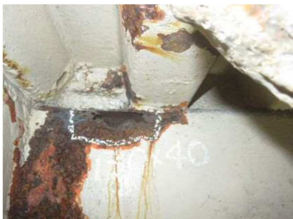
— あ さ ひ ち ょ う 朝日町歩道橋（桁補修） —
