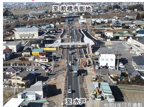
②二之宮地区の工事状況
