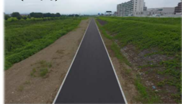
完成した管理用道路の状況 (H29.8)
