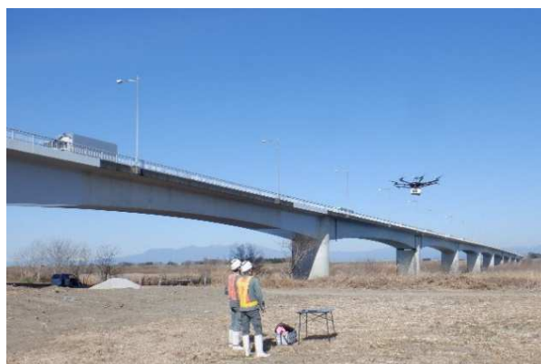
UAVを活用した橋梁点検状況（ し ん じ ょ う ぶ お お は し 新上武大橋）
