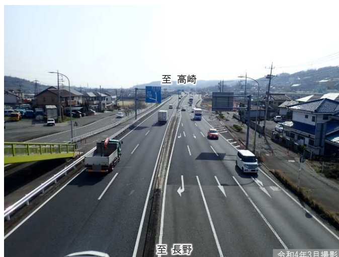
②下野尻歩道橋から久芳橋方面の状況
