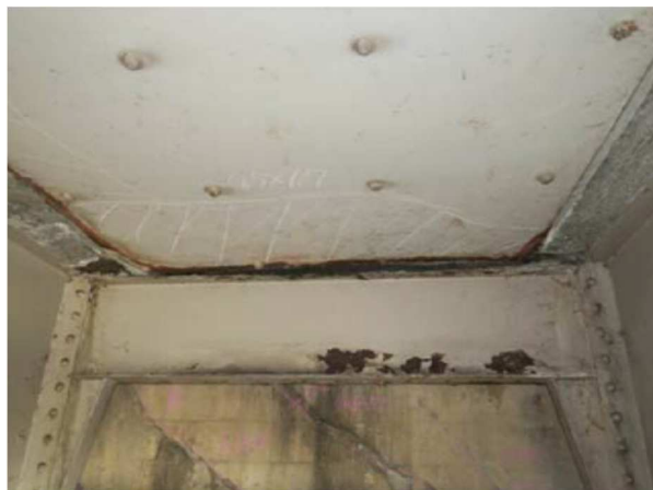
— は ま じ り お お は し 浜尻大橋（床版補修） —
