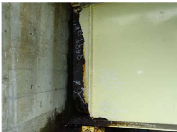
— ほ だ じ ば し 補陀寺橋（桁補修） —
