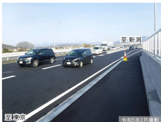
①国道17号・18号合流部（拡幅区間）
