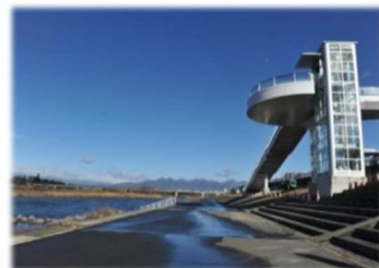
桜観音橋 (人道橋)
