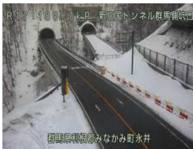
新三国トンネル坑口ロードヒーティング(令和5年2月)
