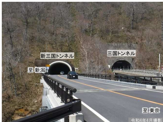
①新三国防災の状況
