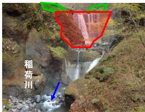
小米平上流砂防堰堤(改築)
