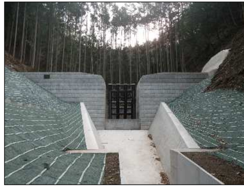
小佐越沢砂防堰堤(完成)
