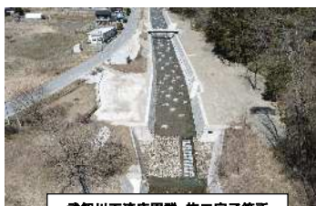
武智川下流床固群 施工完了箇所
