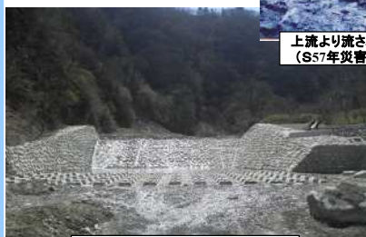
小武川下流床固群 施工完了箇所
