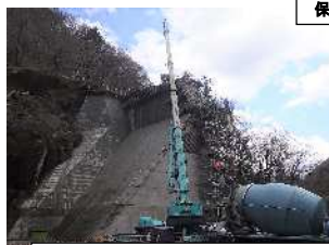
内河内第五砂防堰堤 施工状況
