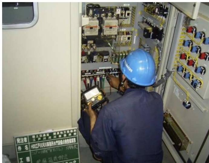
電気・通信設備の点検・整備
