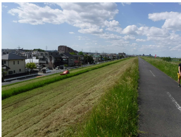
堤防除草(堤防の異常を発見しやすくするため)
