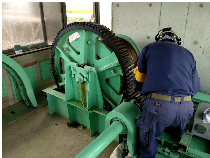
機械設備の点検・整備
