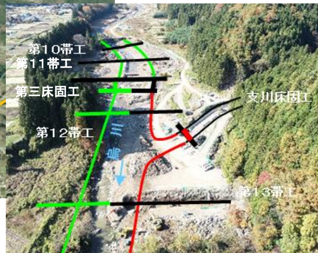
床固群整備状況
