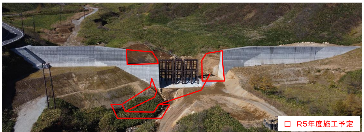
振子沢砂防堰堤(施工中)
