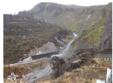
上流の荒廃状況
