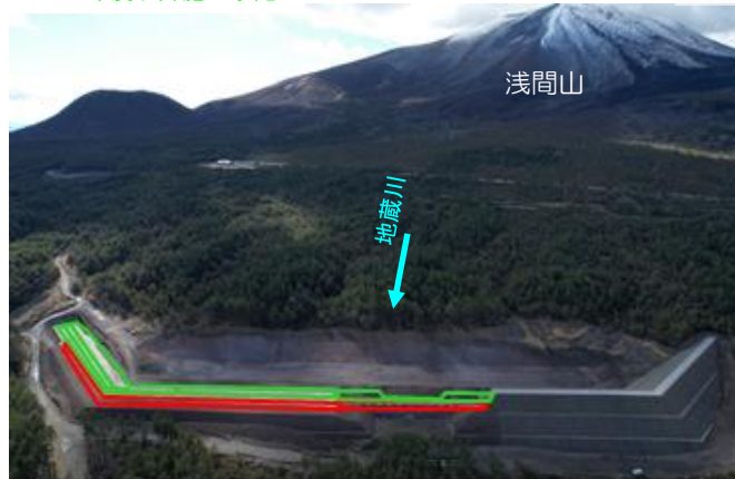
地蔵川第二砂防堰堤(施工中)
