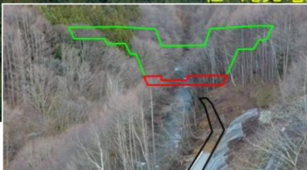
片品上流第二砂防堰堤施工箇所
