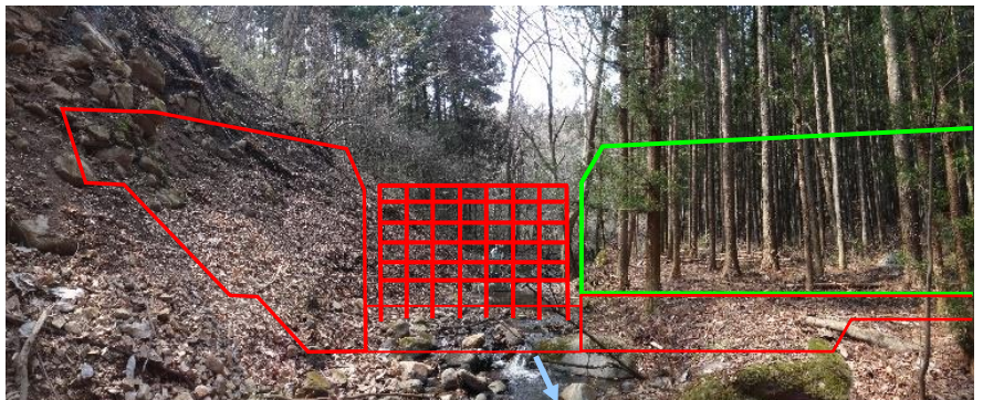
内手川第一砂防堰堤施工箇所
