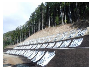
対策工(アンカー工)
