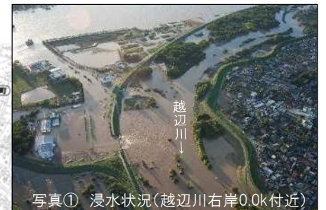
写真① 浸水状況(越辺川右岸0.0k付近)
