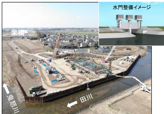
水門基礎部 施工状況(令和5年3月)
