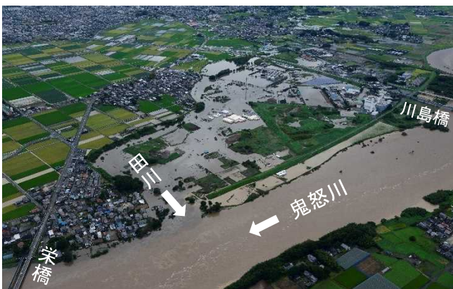
平成27年9月関東・東北豪雨における田川流域の浸水状況(H27.9.10撮影)
