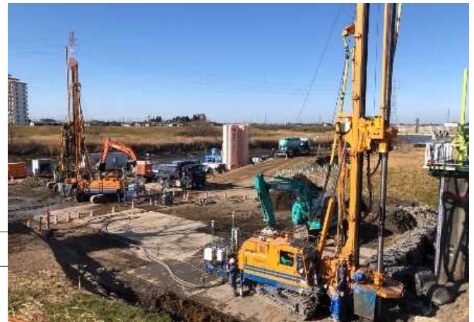
樋管部地盤改良 施工状況(令和5年2月)
