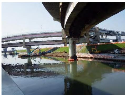
【橋梁下での鋼管矢板施工】
