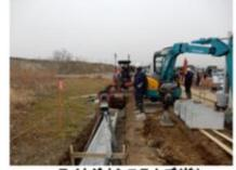
ライカアイコンシステムズ(株)(Leica ICON site excavator)マシンガイダンスシステム
