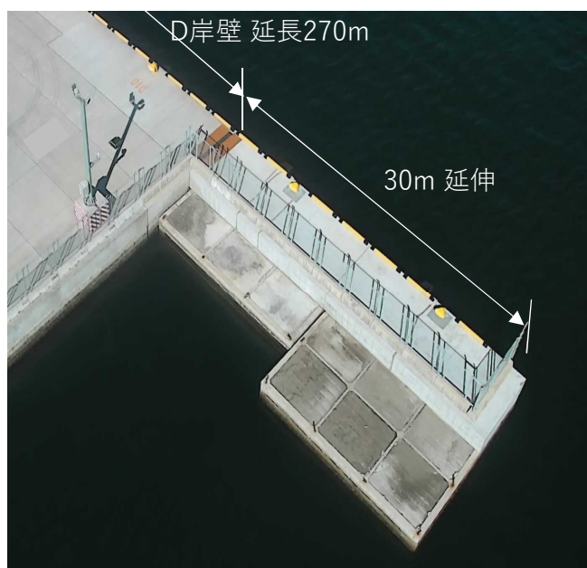
延伸部 30mの施工状況
