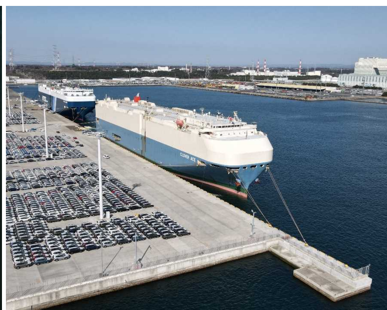
D岸壁 延長300m運用状況
