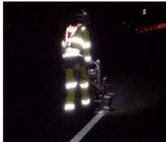
通行止めによる維持工事
