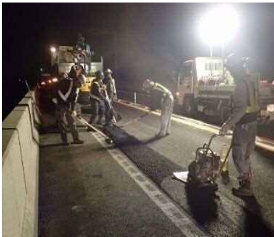
通行止めによる舗装補修工事
