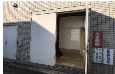
既設発電設備設置箇所
