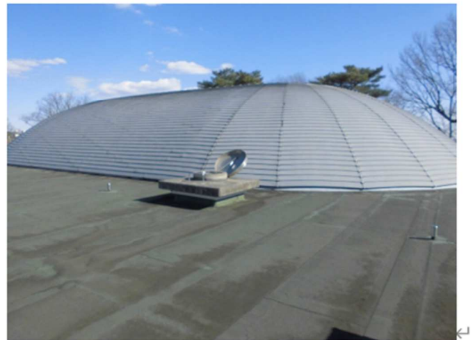
改修箇所（屋上） ←
