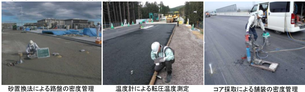
砂置換法による路盤の密度管理 温度計による転圧温度測定 コア採取による舗装の密度管理
