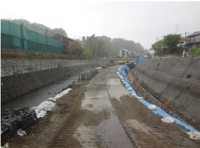
①河道線形の蛇行解消、河道拡幅、河床掘削
