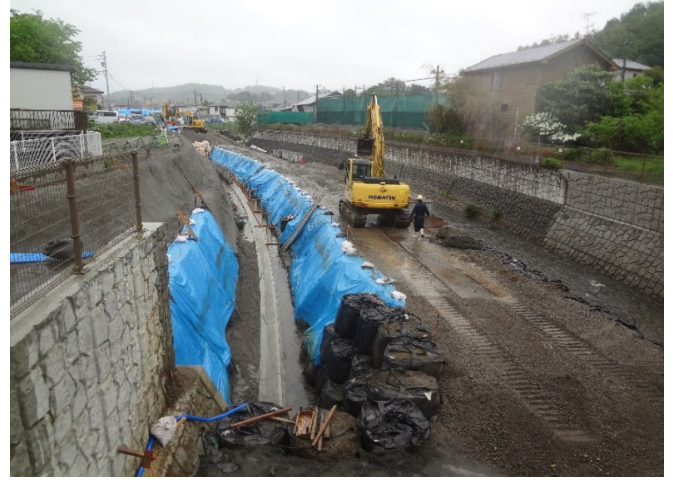
①河道線形の蛇行解消、河道拡幅、河床掘削
