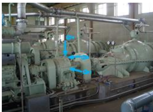
図 3-5 横軸ポンプ設備振動（加速度）測定箇所（参考）
