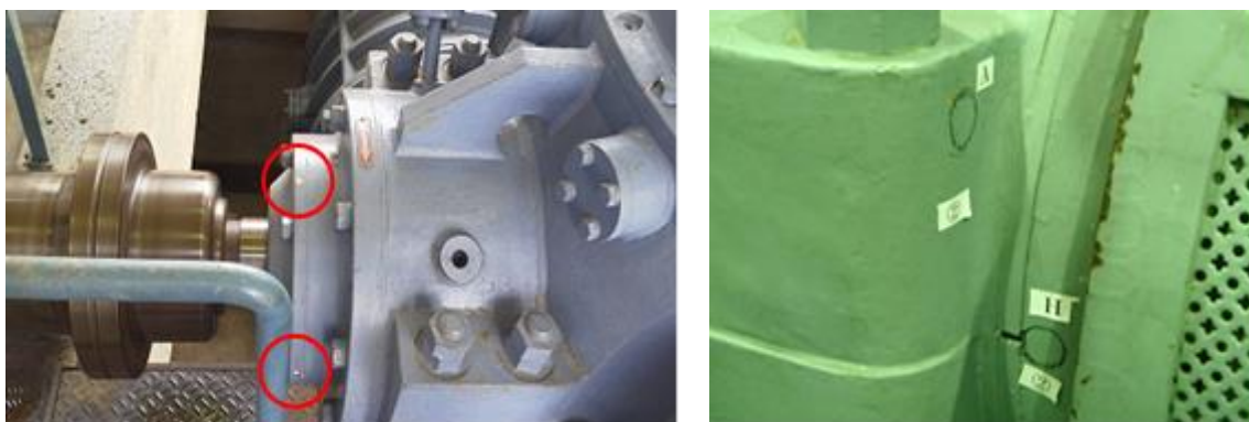
図 3-7 測定点のマーキング事例（左：測定位置のシール表示、右：測定方向の記載）
