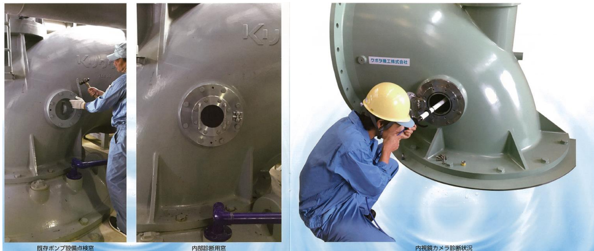
図 4-12 工業用内視鏡に対応した点検窓（出典：クボタ機工株式会社 カタログ）
