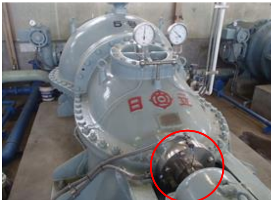
図 2-5 横軸ポンプ設備振動（変位）測定箇所（参考：固定金具による常設方式）
