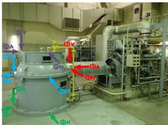
図 3-4 立軸ポンプ設備振動（加速度）測定箇所（参考）
