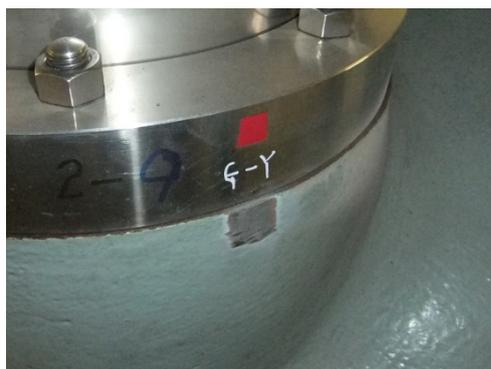
図 3-15 計測箇所にマーキングした例
