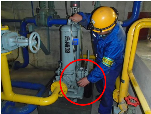
写真 6-3 オイルフィルター部からのサンプリング
