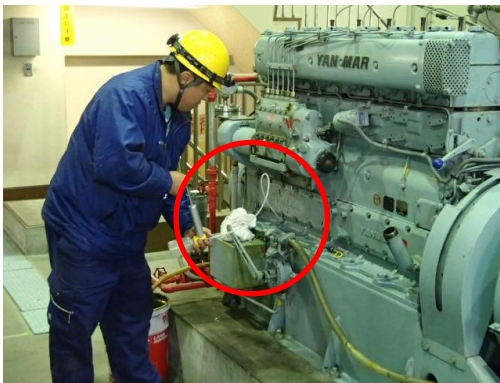
写真 6-1 オイルゲージ孔からの サンプルング
