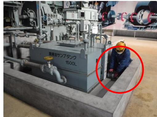
写真 6-4 サンプタンクからのサンプリング
