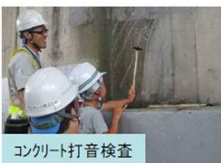
コンクリート打音検査
