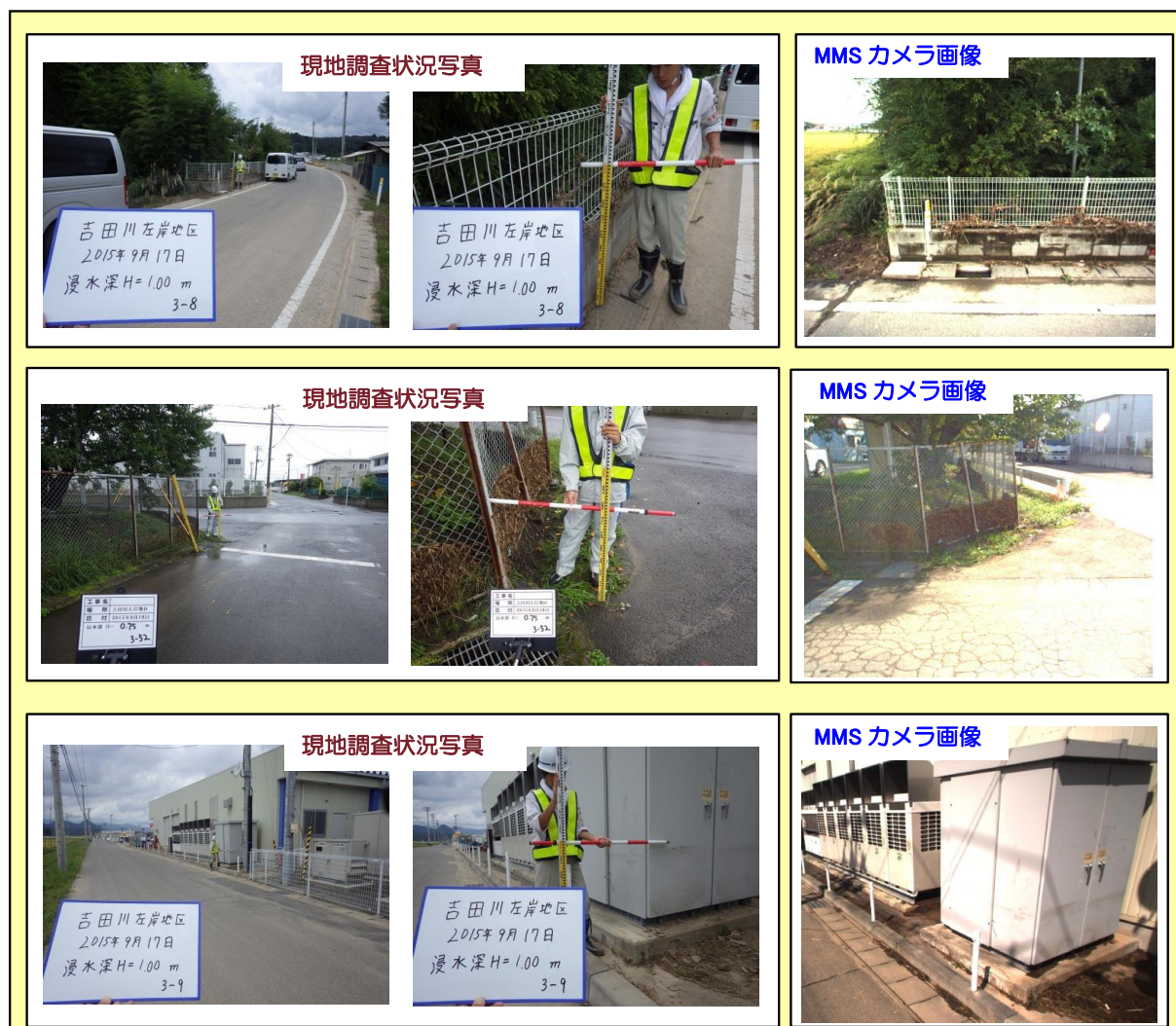
図 4-1 浸水痕跡調査と現地調査との比較
