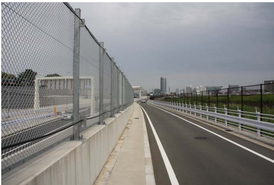
鶴見川上流側から
