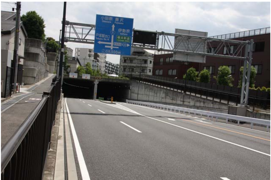
港南区方面側から
